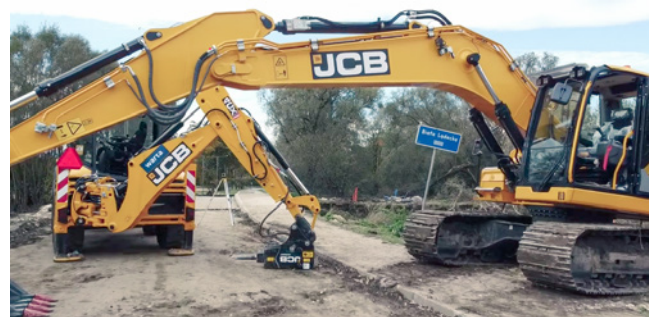
寄贈した重機による復旧作業
