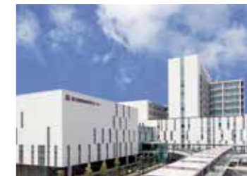
オープンイノベーションセンター (大阪府吹田市岸部新町)
