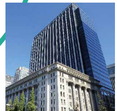
明治安田生命ビルと明治生命館 (東京都千代田区)
