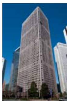
新宿センタービル
