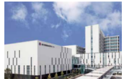
オープンイノベーションセンター (大阪府吹田市岸部新町)
